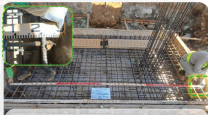
Checking of Actual Length = 4250 mm
