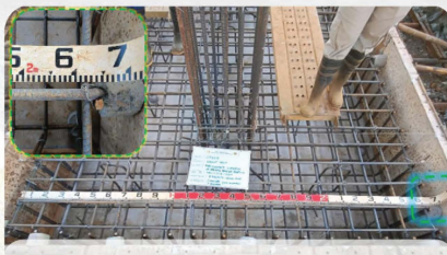
Checking of Actual Width = 2650 mm
